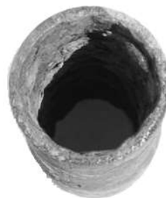
Slika 2 - Opšta korozija cevi bušotina
