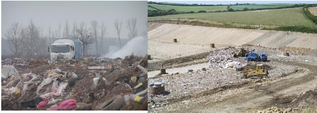
Slika 3 – U upravljanju otpadom u Srbiji je neophodna drastična promena – od tipičnog zvaničnog smetlišta (levo) do izgradnje savremenih regionalnih sanitarnih deponija (desno)
