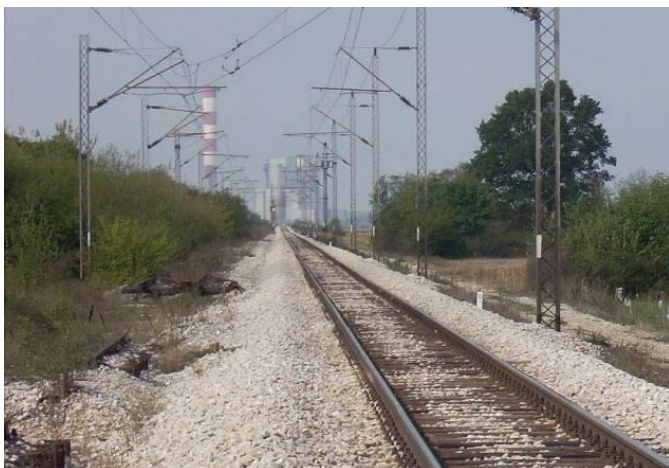
Slika 8.1 Pruga za prevoz uglja u termoelektranu Nikola Tesla u Obrenovcu
