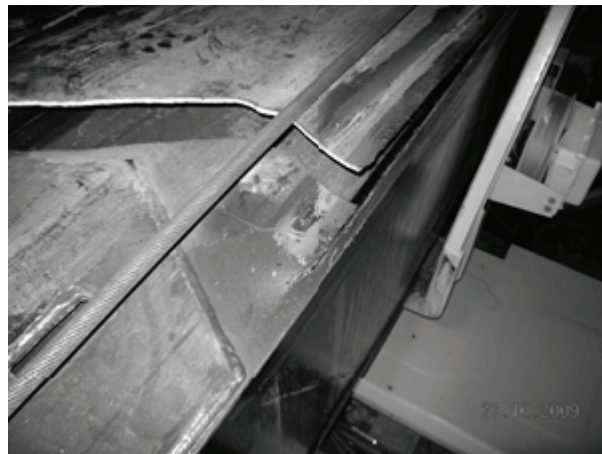
Slika 2: Priprema segmenata autodizalice za sanaciju
